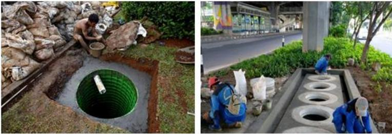
Gambar 6.4. Sumur resapan
